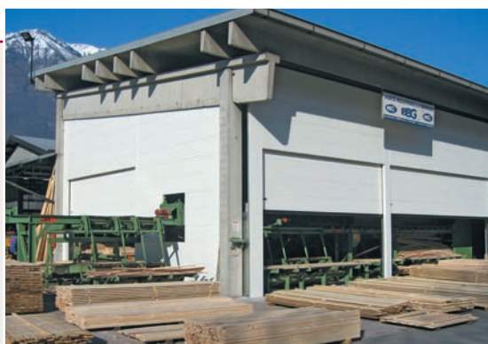
Applicazione di portoni sezionali non bilanciati presso una segheria che necessitava dell'installazione dei portoni senza dover interrompere l'attività.
