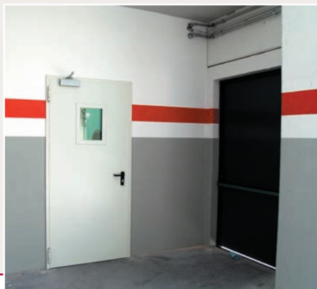
Vista esterna porta pedonale rei120 u.s., provvista di oblo', chiudiporta esterno e maniglione antipanico.
