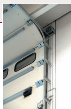
Vista interna sistema di scorrimento a soffitto.
