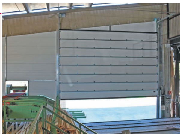
Vista interna dove sono visibili gli omega di rinforzo, nonché la pannellatura laterale in tinta del portone.
