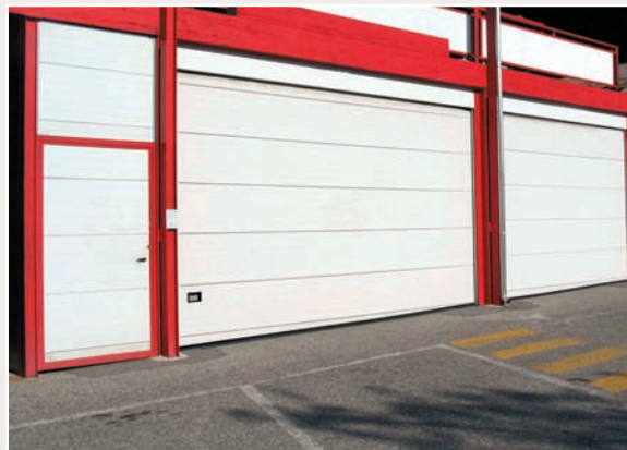
Installazione di portoni sezionali su pavimento inclinato.
