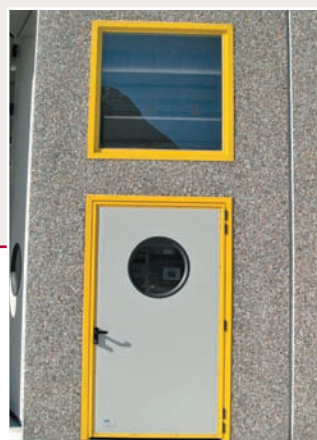
Porta pedonale uscita di sicurezza in profili di alluminio e pannello coibentato.
