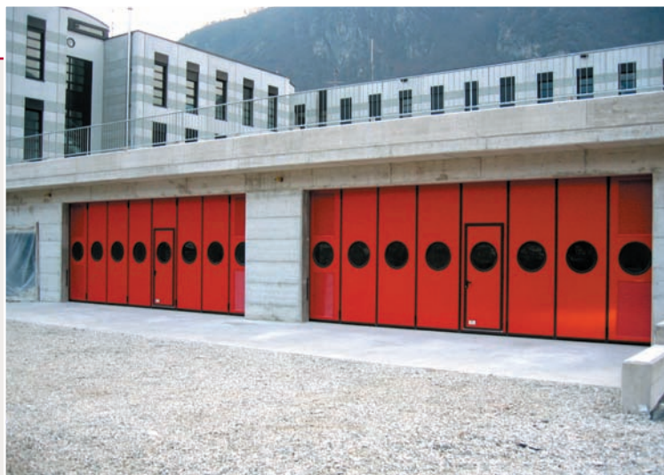
Portone a libro 4+4 ante ad apertura bilaterale con oblò circolari, porta pedonale inserita e griglie di areazione.
