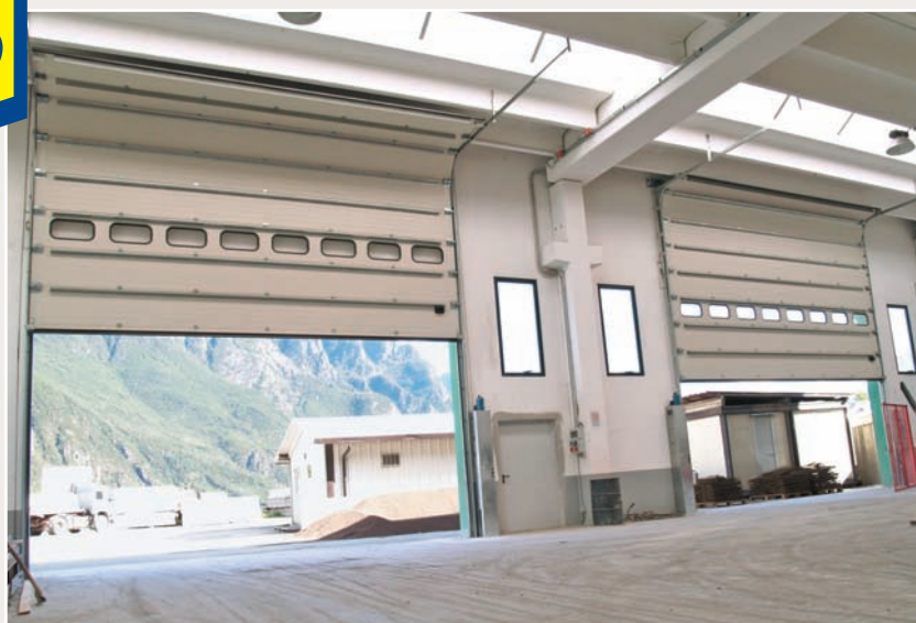
Vista interna di n. 2 portoni con "apertura parzialmente verticale", dove sono visibili le "consolle" a pavimento.
