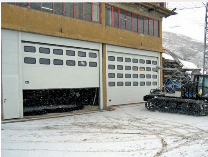
Portoni sezionali con inserimento multiplo di oblo', traverse in tinta e portina laterale; applicazione in alta montagna.
