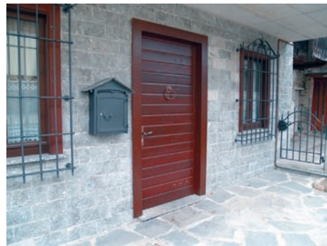
Porta pedonale laterale
